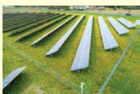
Figura 2. Parc cu panouri fotovoltaice
